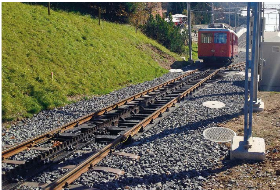
Schwenkweiche oberhalb der Station Rigi-Kaltbad. In der Steuerkabine ist die Weichensteuerung untergebracht, die auf den PSSuniversal Steuerungs- und E/A-Modulen von Pilz basiert
